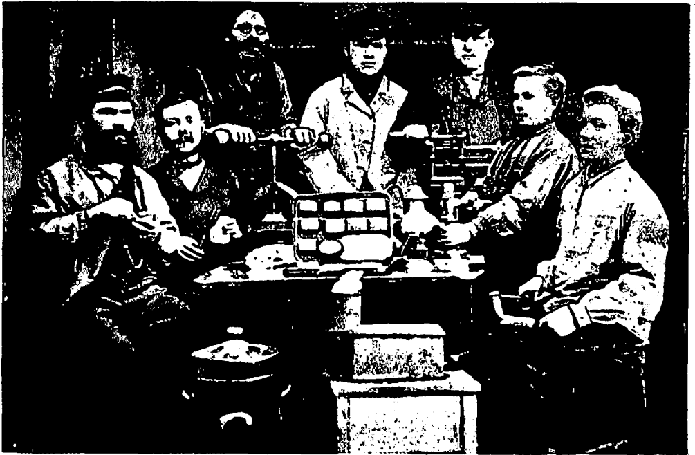
Fig. 2. Jacob J. Helwig med arbeidere ca. 1875. Bildet viser ulike typer tidlig emballasje. Til venstre på bordet sees en håndpresse for lokk og til høyre en sikkemaskin for utforming av loddekant. Personene på bildet illustrerer de ulike prosessene som skulle til for å lage blikkemballasje.
